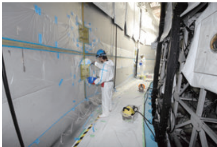
図5 外水槽におけるタンク壁面の止水工事の様子。青い浮床の上で作業。右側には口径20 cmのPMTが見えている。
